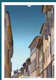
06 les débords de toitures
