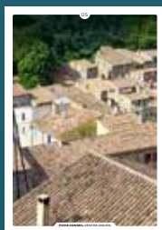
05 les toitures en tuiles rondes
