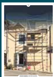
13 les modifications de baies
